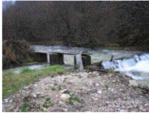
Slika 1. Zahvat vode i dovod na turbinu
